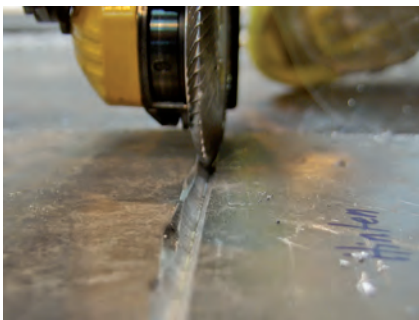
Fräsen einer Kehle mit dem Schweißnahtwurzelöffner
